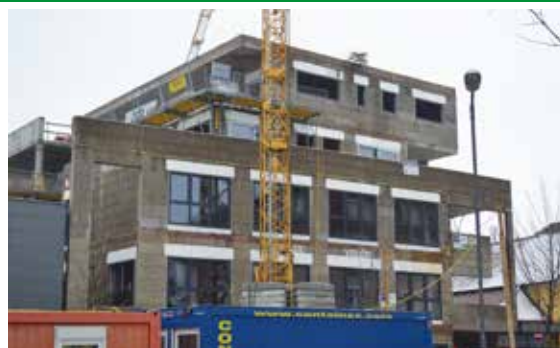
Baufortschritt im Feber 2014
