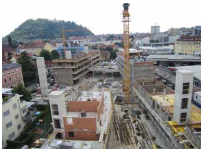
Großbaustelle im Zentrum von Graz.
